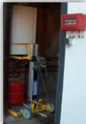
Pose / dépose d'un chauffe eau
