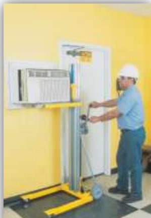
Pose d'une climatisation.
