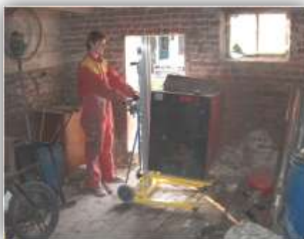
Enlèvement d'une chaudière
