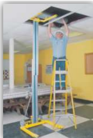
Pose / dépose d'une gaine
