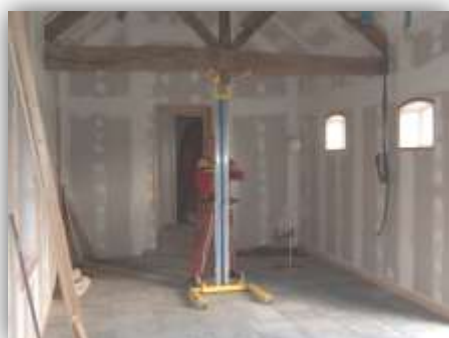
Mise en place d'une poutre
